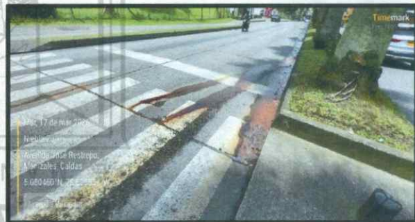
Avenida Villa Pilar, frente a Bata con presencia de infiltraciones
