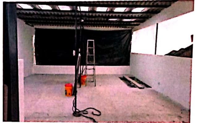
Foto No. 2 Parte interna del tercer nivel, se aprecia n los muros de las paredes, la cubierta en teja de policarbonato y la estructura metálica.
