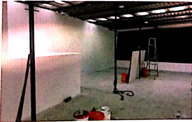
Foto No. 3 Parte interna del tercer nivel, se aprecia n los muros de las paredes, la cubierta en teja de policarbonato y la estructura metálica.
