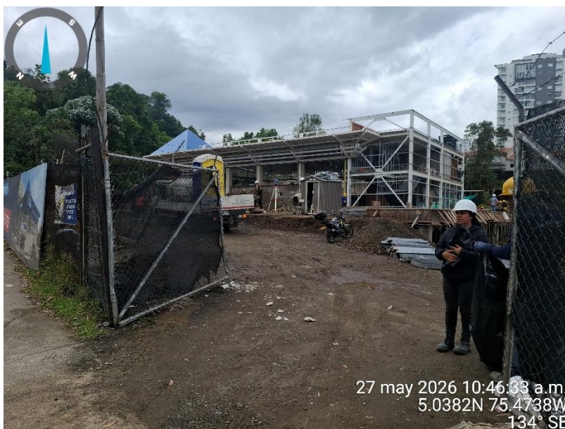
Fotografía 6: Vista de las labores constructivas de la primera licencia de construcción otorgada Resolución 25-1-0236 LC. Captura Propia
