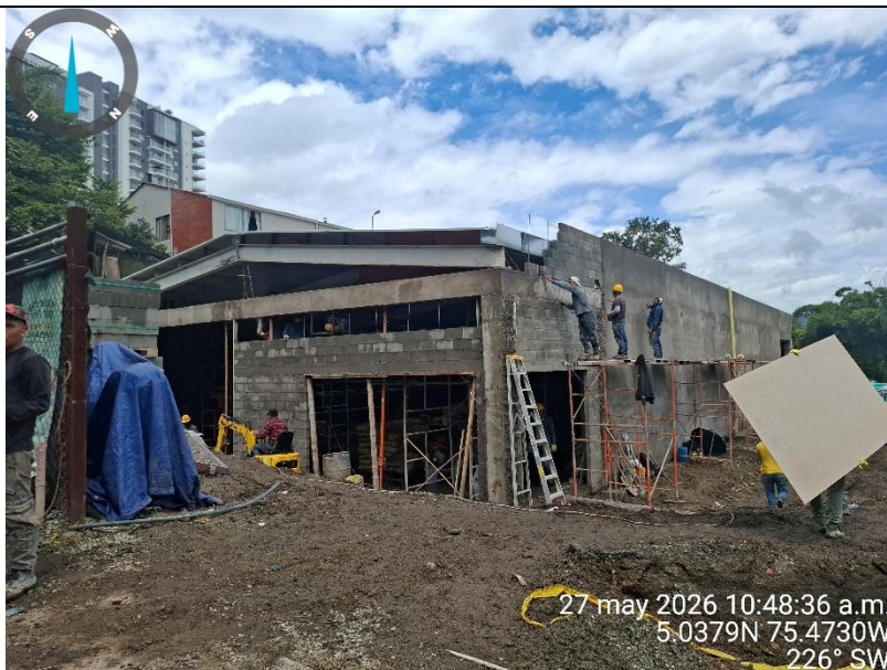
Fotografía 7: Vista de las labores constructivas de la segunda licencia de construcción otorgada Resolución 26-1-0051 LC. Captura Propia
