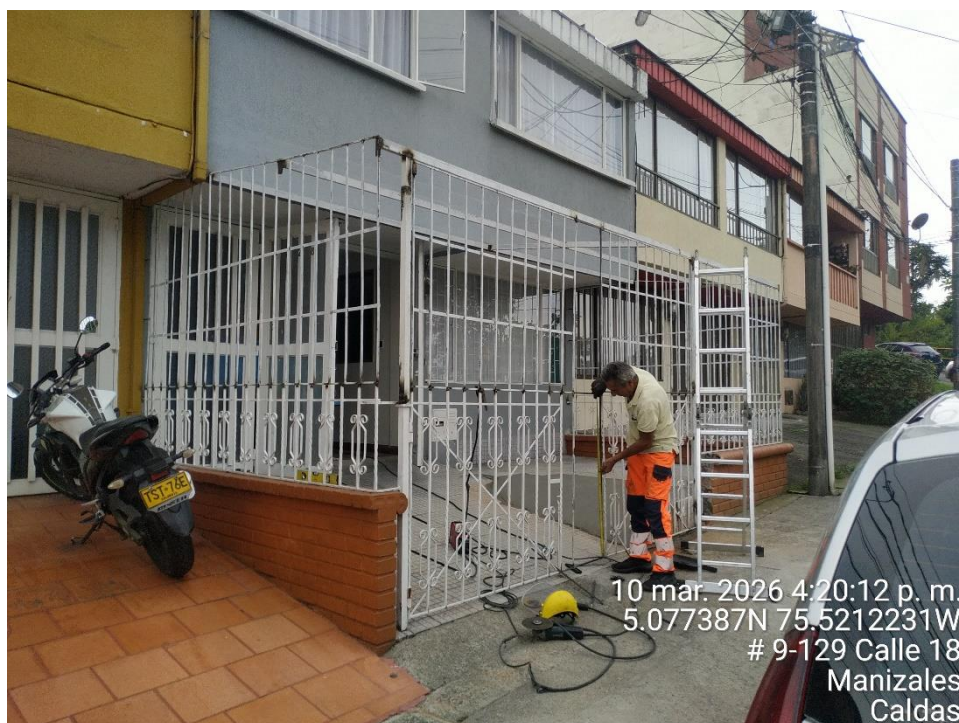
Fotografía 2 Actividades de construcción en curso - Construcción de cerramiento en perfilera metálica Capturas propias
