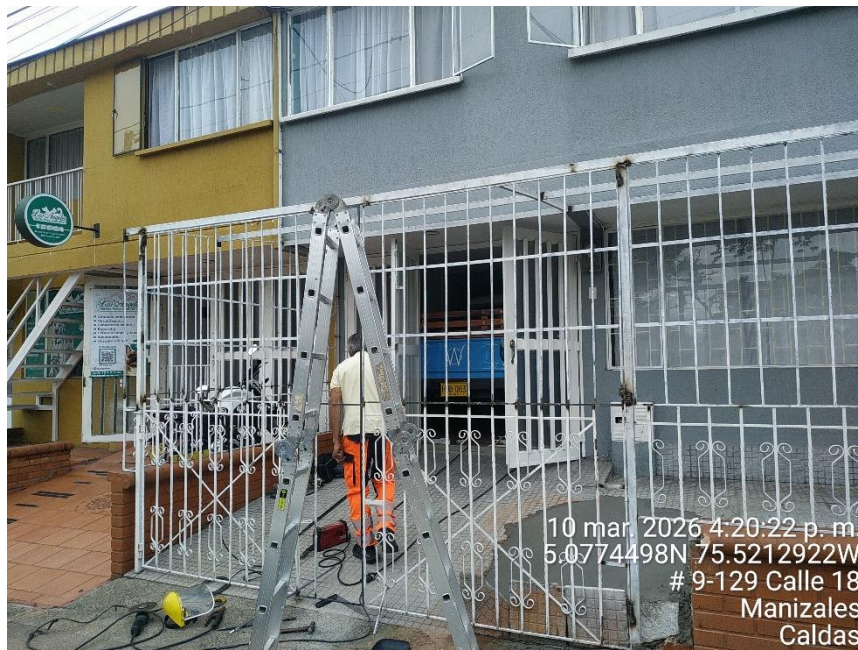
Fotografía 3 Actividades de construcción en curso – Construcción de cerramiento en perfiles metálicos con estructura de cubierta Capturas propias
