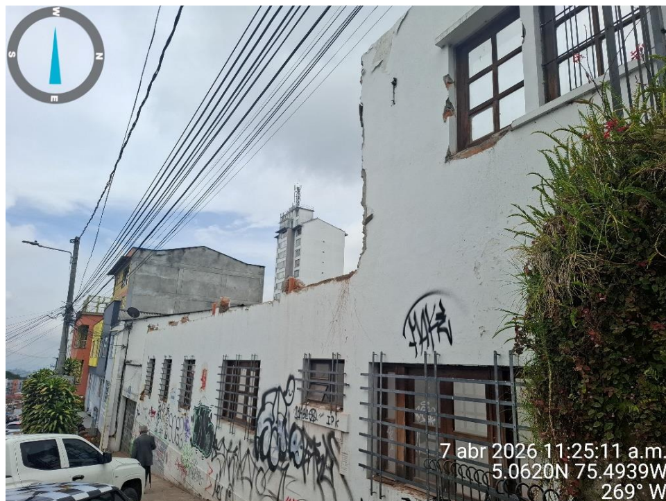
Fotografía 4 Demolición de inmueble preexistente Capturas propias
