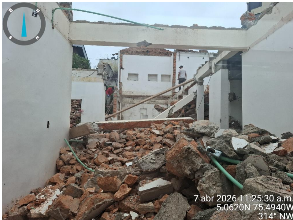
Fotografía 7 Actividades de demolición en curso de inmueble preexistente Capturas propias
