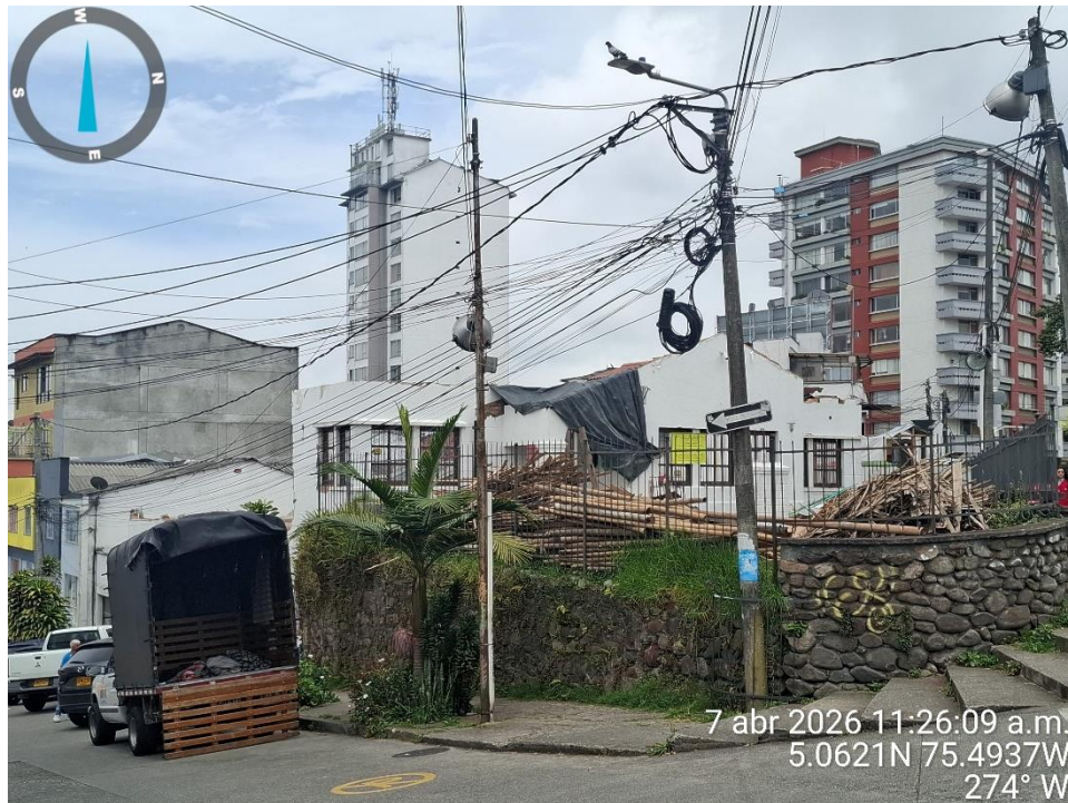
Fotografía 1 Actividades de demolición en predio objeto de solicitud – Carrera 23 54 96 Belén Capturas propias
