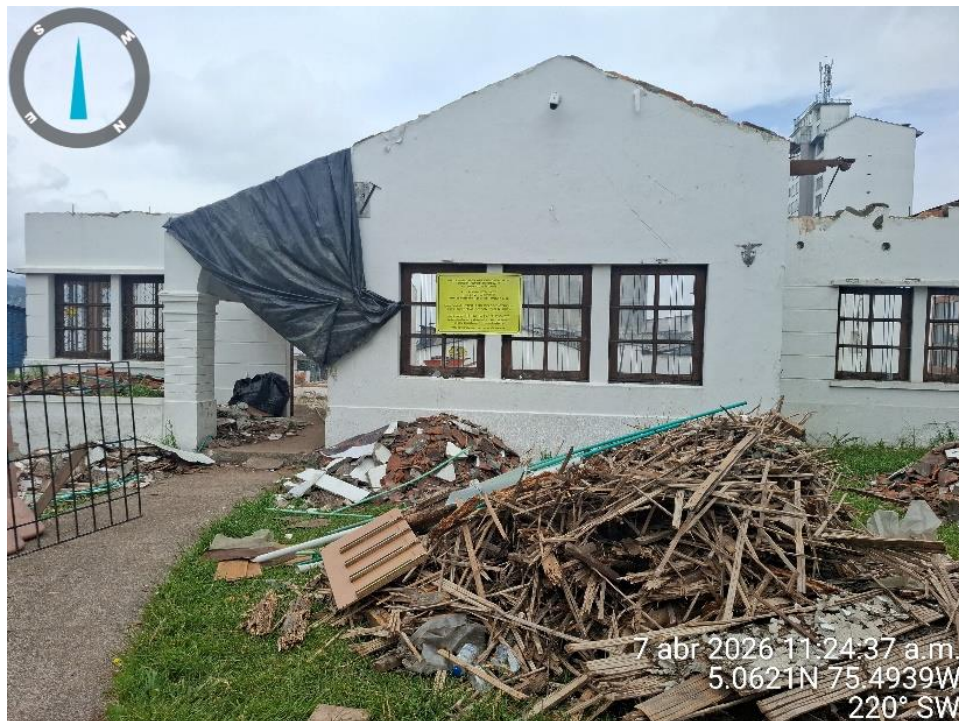
Fotografía 2 Actividades de demolición en predio objeto de solicitud – Carrera 23 54 96 Belén Capturas propias
