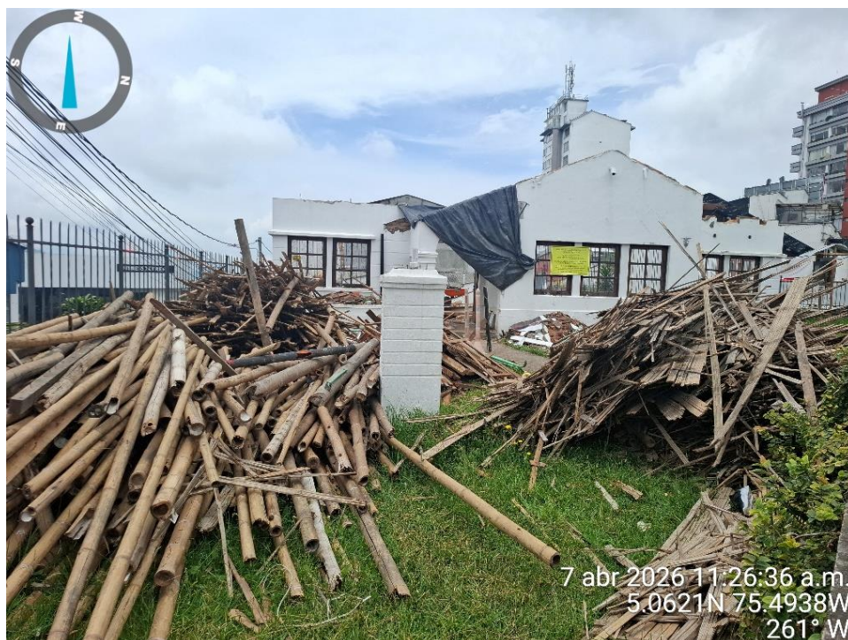
Fotografía 5 Materiales producto de la demolición Capturas propias
