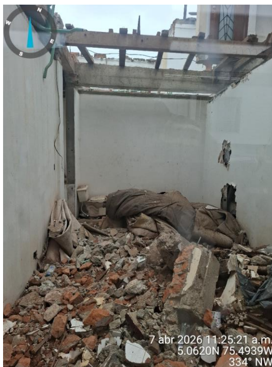
Fotografía 6 Actividades de demolición del inmueble preexistente Capturas propias
