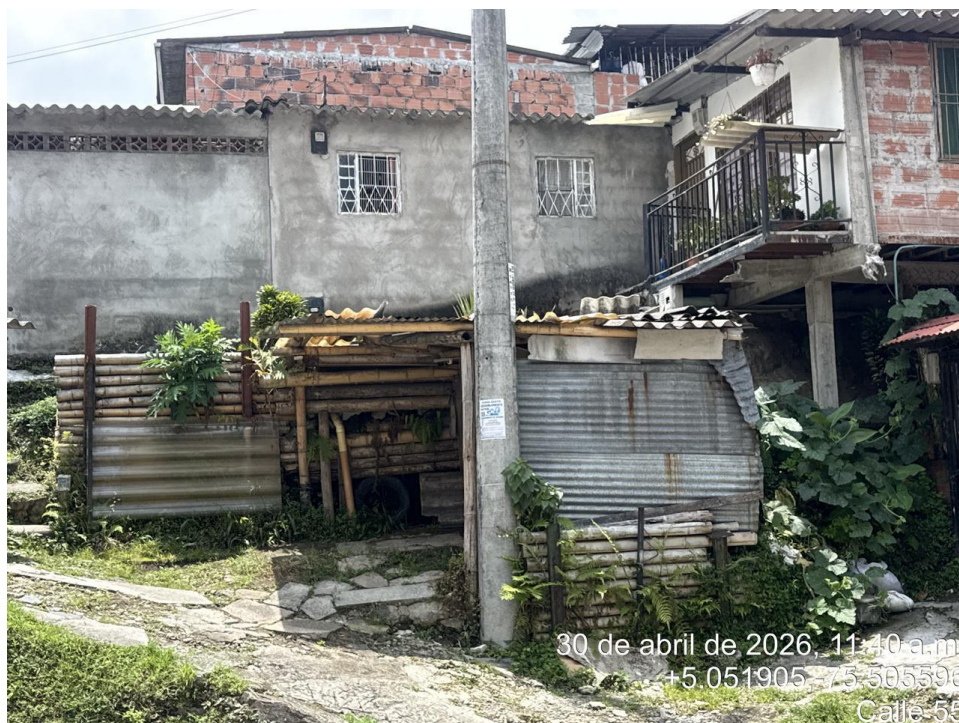
Fotografía 2 Estructura No. 2 ocupando parte del predio con nomenclatura Carrera 41 Calle 55A Capturas propias
