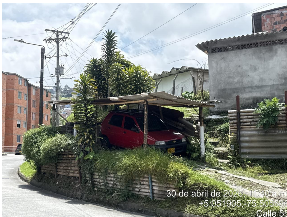
Fotografía 3 Estructura No. 1 ocupando parte del predio con nomenclatura Carrera 40 54A 01 Capturas propias
