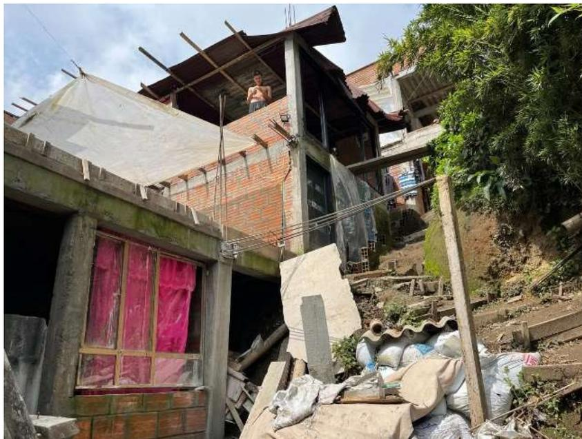
**Foto No 1.** Fachada principal del inmueble, se observa la estructura en pórticos de concreto y cerramiento en mampostería.
