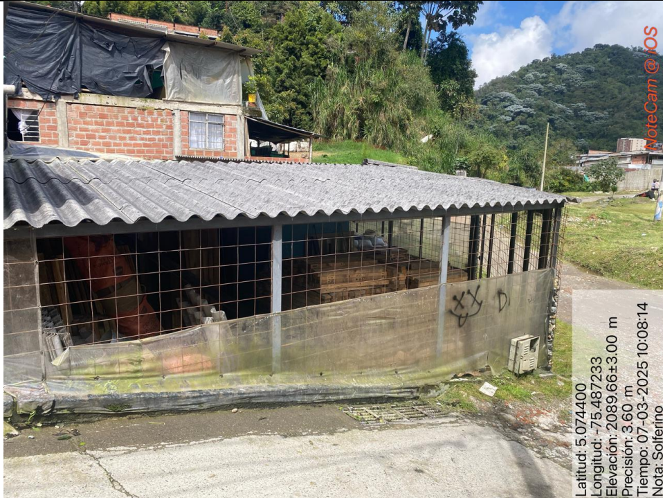
Imagen No. 4 – Cerramiento en Zona Verde, Carrera 7K Calle 53. Fuente: Equipo Técnico de Vigilancia y Control Urbanístico.
