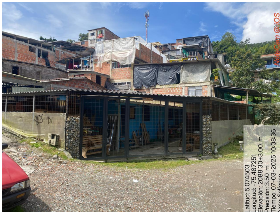
Imagen No. 3 – Cerramiento en Zona Verde, Carrera 7K Calle 53.
