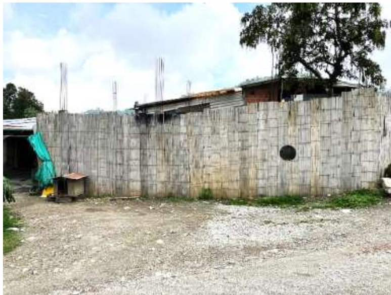
Foto No 1. Fachada principal del inmueble que se encuentra invadiendo el predio del municipio
