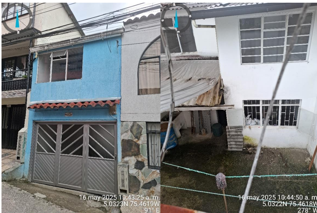
Imágenes No. 1 y No. 2 – Condiciones actuales del predio. Fuente: Equipo de vigilancia y control urbanístico.
