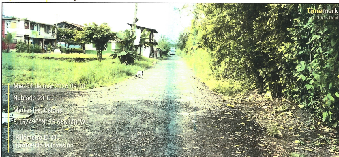
Imagen No. 2: Vía acceso e interna Centro Poblado Km 41
