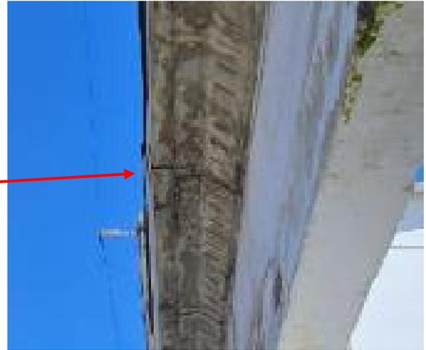
La parte superior del muro presenta pequeñas fisuras, no representan riesgos para la estabilidad global del muro.
