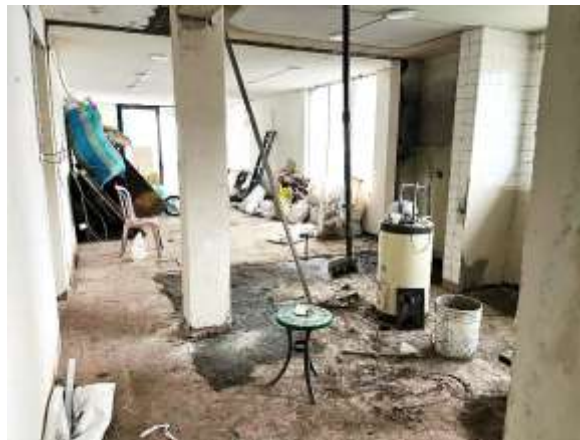
Foto No 2 y 3. Adecuación del local comercial, donde se aprecia la demolición de muros.
