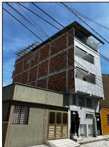
Foto No. 4 Fachada lateral izquierda.
