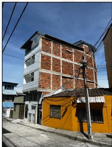
Foto No. 3 Fachada lateral derecha.
