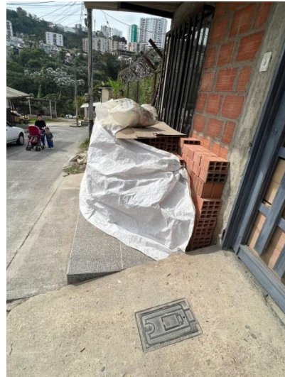
Foto No. 2 Material de construcción (ladrillo farol).
