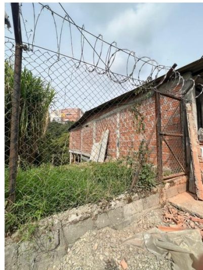
Foto No. 4 Detalle Vivienda ya construida.
