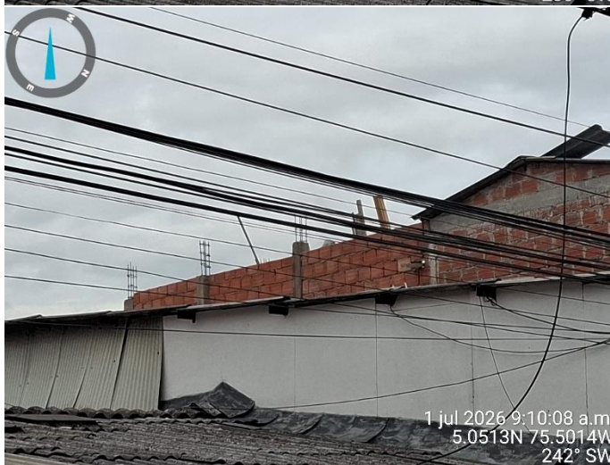
Fotografía 3-4: Vista Frontal del predio objeto de visita donde se evidencia los muros que generan la ampliación. Captura propia
