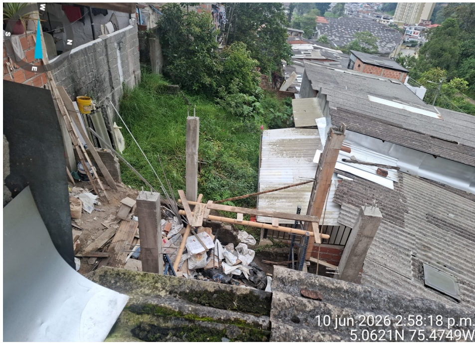
Imagen No. 4 – Obra nueva en curso. Fuente: Equipo Técnico de Vigilancia y Control Urbanístico.
