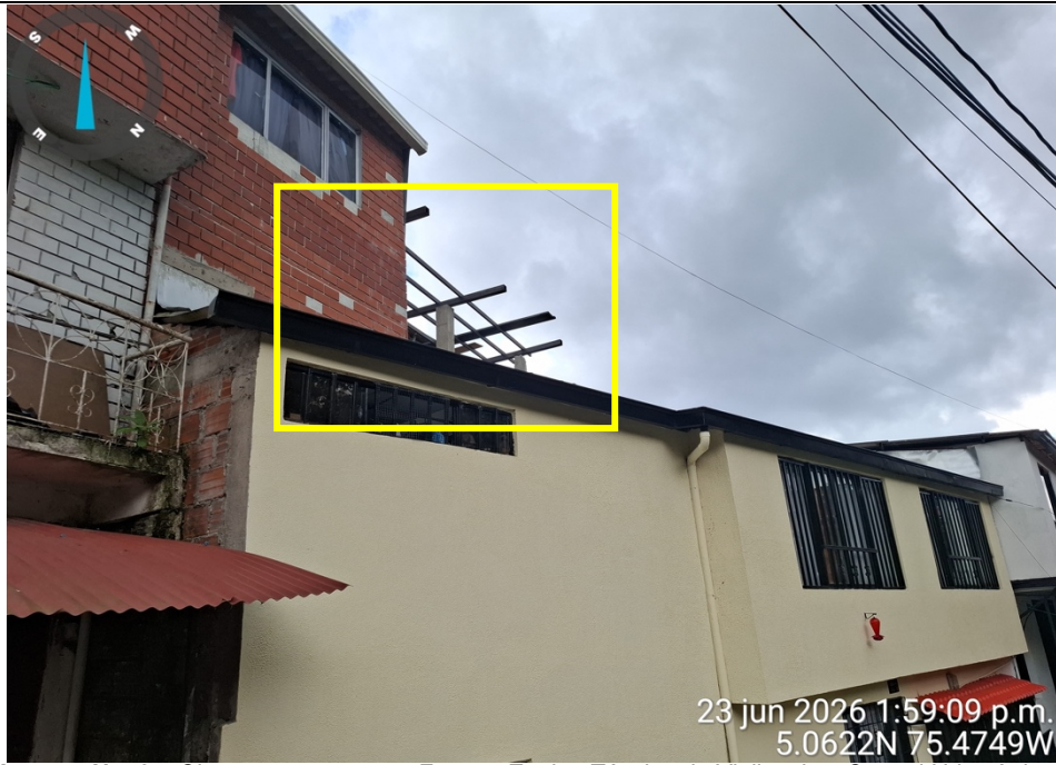
Imagen No. 3 – Obra nueva en curso. Fuente: Equipo Técnico de Vigilancia y Control Urbanístico.
