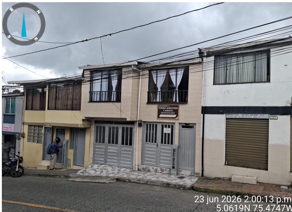
Imagen No. 2 – Predio objeto de la intervención. Fuente: Equipo Técnico de Vigilancia y Control Urbanístico.
