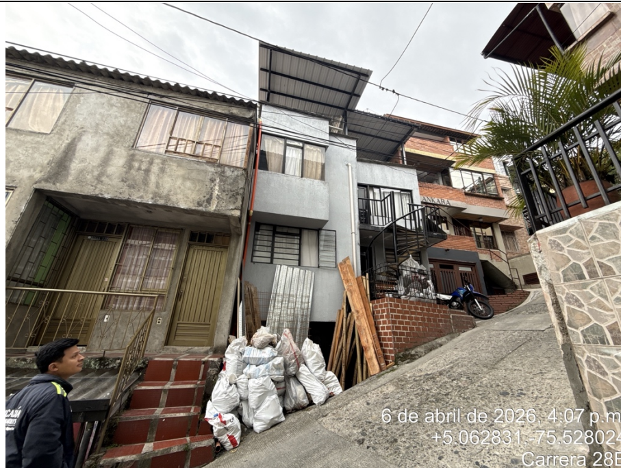
Imagen No. 3 – Estado actual del predio objeto de consulta. Fuente: Equipo Técnico de Vigilancia y Control Urbanístico.
