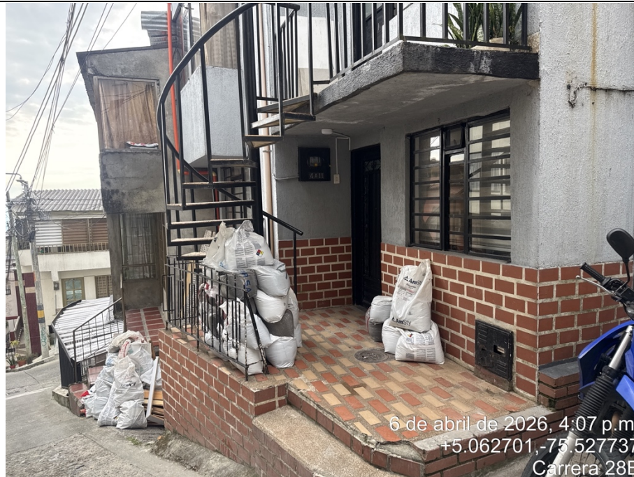
Imagen No. 5 – Acumulación de materiales de construcción y residuos de construcción y demolición. Fuente: Equipo Técnico de Vigilancia y Control Urbanístico.
