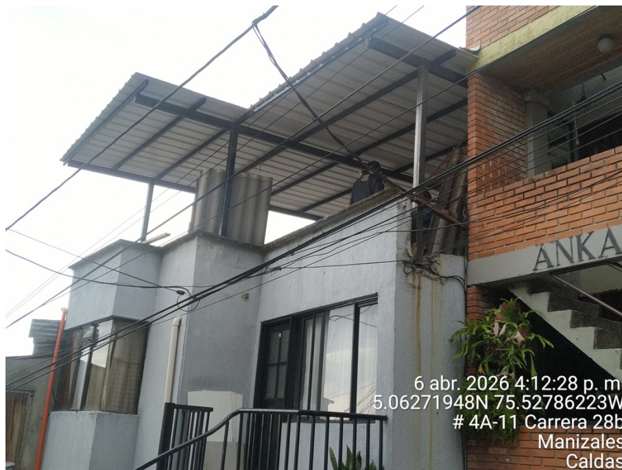
Imagen No. 6 – Construcción de terraza. Fuente: Equipo Técnico de Vigilancia y Control Urbanístico.
