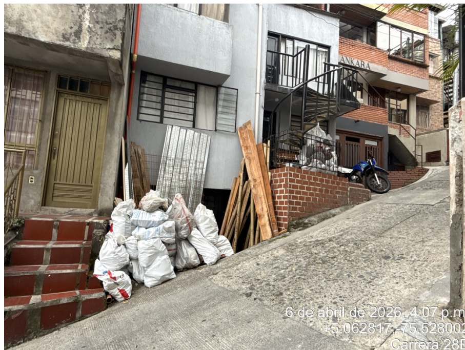
Imagen No. 4 – Acumulación de materiales de construcción y residuos de construcción y demolición frente al predio. Fuente: Equipo Técnico de Vigilancia y Control Urbanístico.
