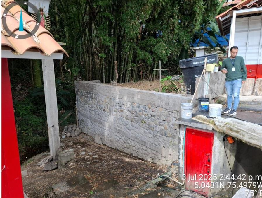
**Fotografía 2** Muro de contención construido
