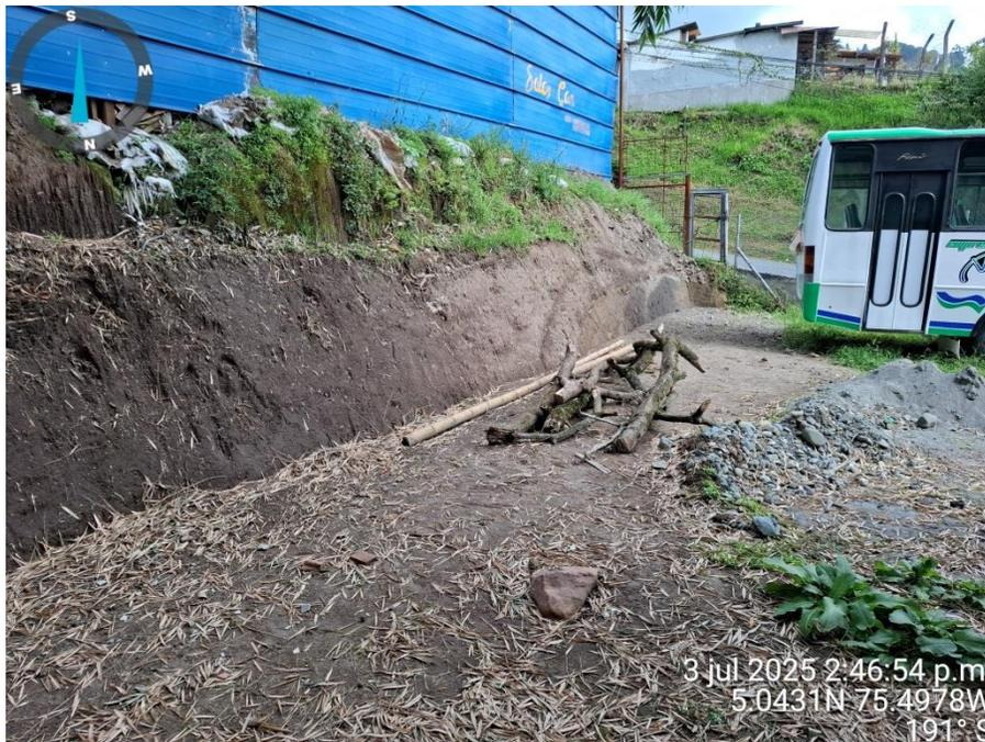
**Fotografía 5** Actividades de corte y excavación en costado lateral del sitio objeto de solicitud
