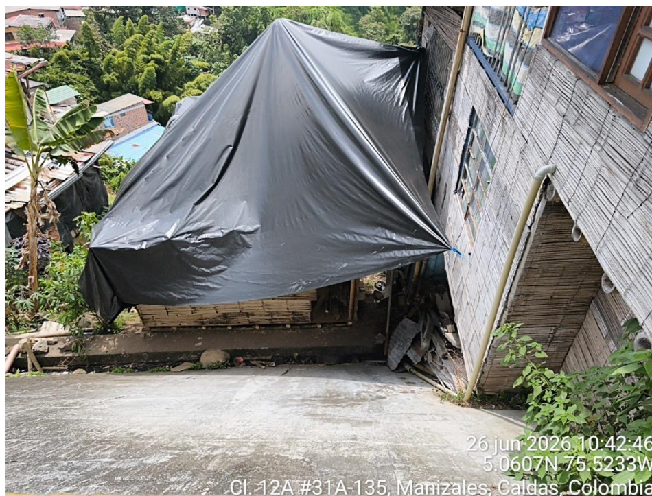
Fotografía 3 Construcción de tipo artesanal en sitio contiguo a pantalla de contención Capturas propias
