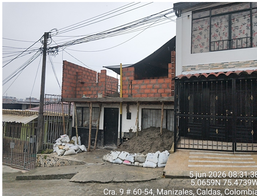
Imagen No. 2 – Construcción de segundo piso. Fuente: Equipo Técnico de Vigilancia y Control Urbanístico.
