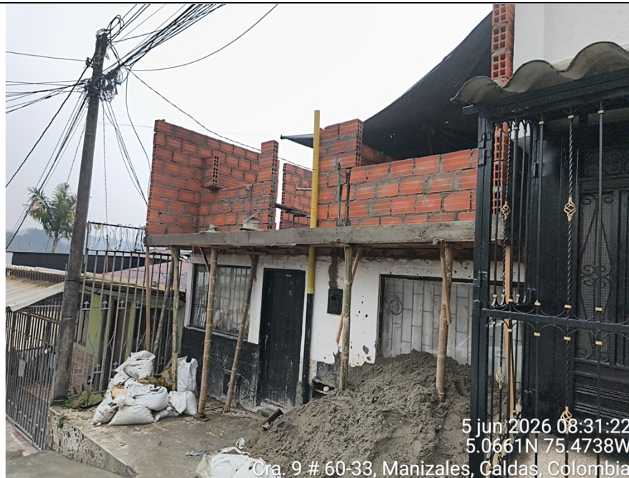
Imagen No. 3 – Construcción de segundo piso. Fuente: Equipo Técnico de Vigilancia y Control Urbanístico.
