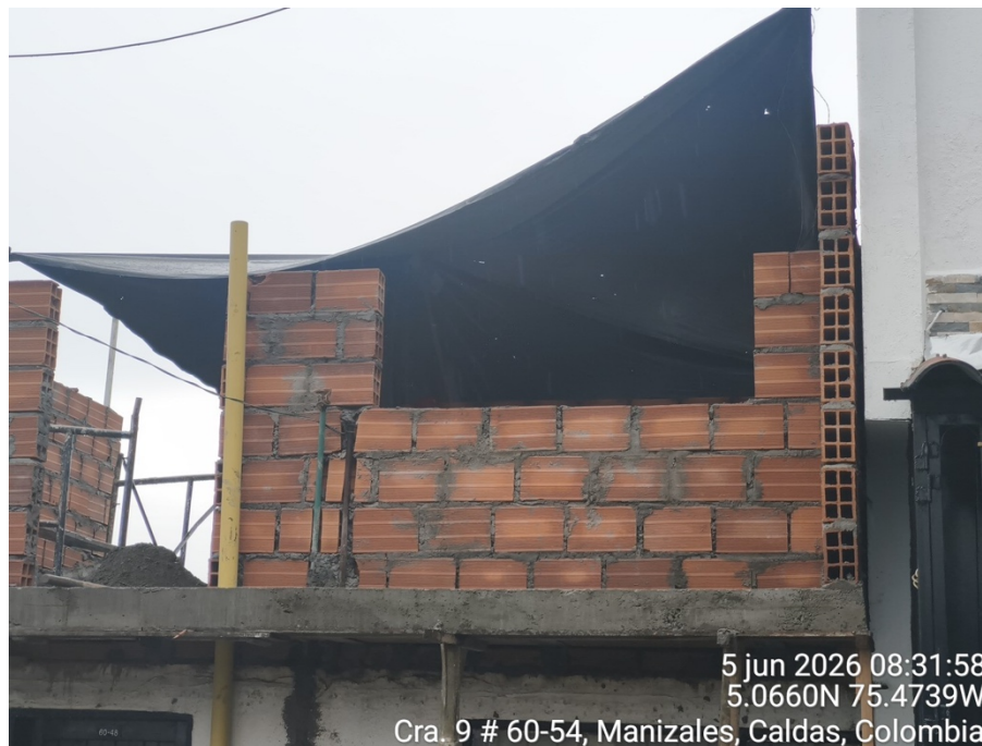
Imagen No. 4 – Construcción de segundo piso. Fuente: Equipo Técnico de Vigilancia y Control Urbanístico.
