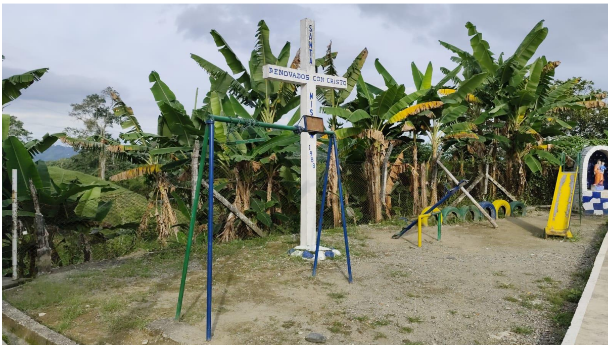
Los juegos infantiles se encuentran en deterioro
