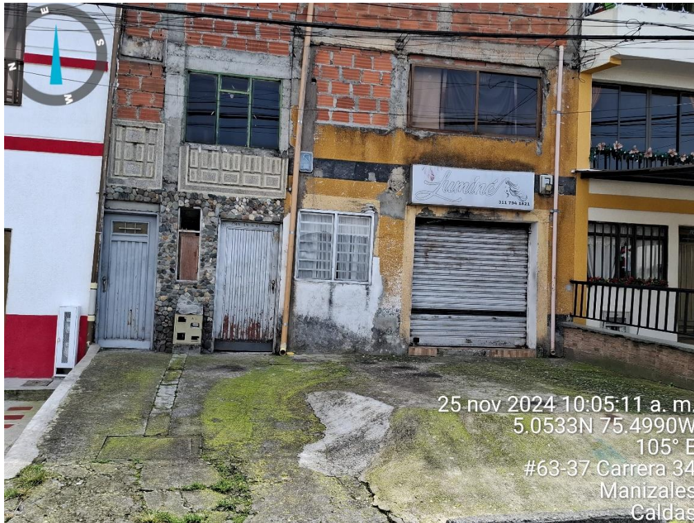
Imagen No. 2 – Evidencia fotográfica de visita técnica de inspección. Fuente: Equipo técnico de vigilancia y control urbanístico. Fecha: 25 de noviembre de 2024.
