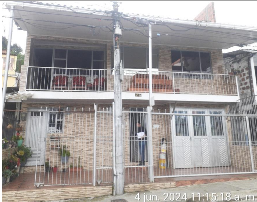
Imagen No. 3 – Evidencia fotográfica vivienda con dirección carrera 12 No. 1B-05.
