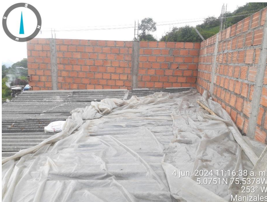
Imagen No. 4 – Evidencia fotográfica de labores constructivas en vivienda carrera 12 No. 1B-05.
