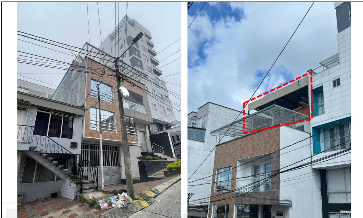
Fotografías No. 3 y 4. Comparativo entre fotografías tomadas en el mes de Octubre de 2023 y el día de la visita. Punteado en rojo: 5 o piso en construcción en el edificio Dimarni.
