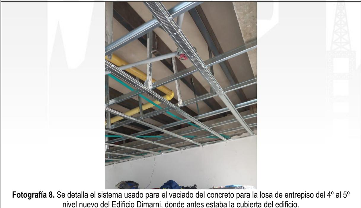
**Fotografía 8.** Se detalla el sistema usado para el vaciado del concreto para la losa de entrepiso del 4° al 5° nivel nuevo del Edificio Dimarni, donde antes estaba la cubierta del edificio.
