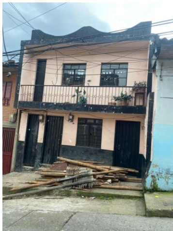
Foto No 1. Fachada del inmueble con material de obra en el antejardín (espacio público), dirección Carrera 17 No. 16-28/32.
