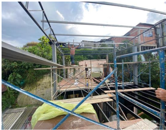
Foto No 5. Reforzamiento en estructura metálica y personal de obra sin elementos de protección personal
