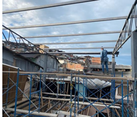
Foto No 4. Cerchas y correas para la cubierta, personal de obra sin elementos de protección personal.
