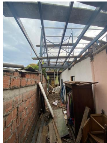
Foto No 2. Reforzamiento con estructura metálica, viga y viguetas de entepiso para una posterior instalación de piso
