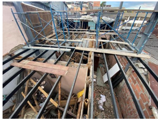
Foto No 6. Escombros o material sobrante de los muros en bahareque que fueron reemplazados por la estructura metálica.
