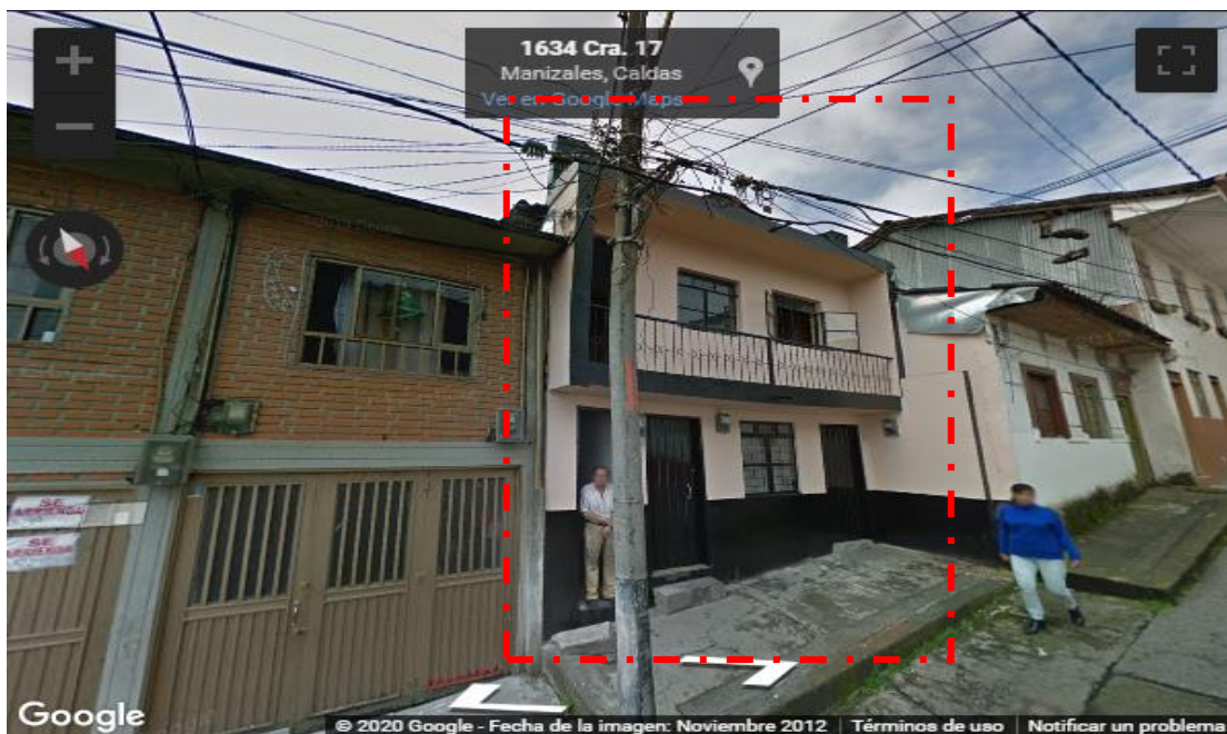
IMAGEN No 2. Imagen tomada por Google Street view, Noviembre 2012, inmueble ubicado en la direcciones CARRERA 17 No. 16-28/32.
