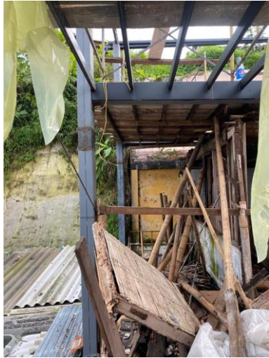
Foto No 3. Reforzamiento en estructura metálica, columna, vigas y viguetas, en este caso se esta reforzando el 2 piso y ampliando al 3 piso.
