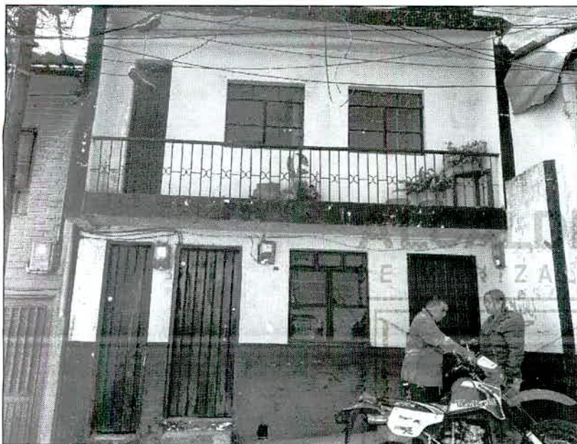
Foto 1. Fachada de la vivienda (K 17 # 16 – 28/32)
