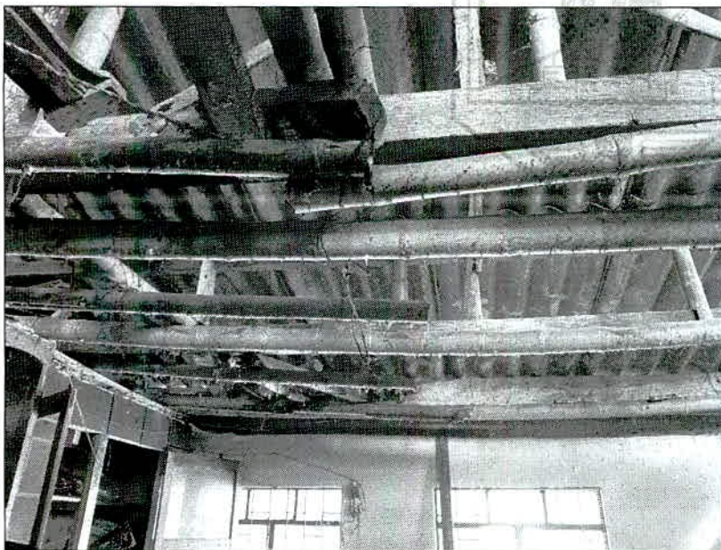
Foto 3. Estructura de guaduas en estado de deterioro.
