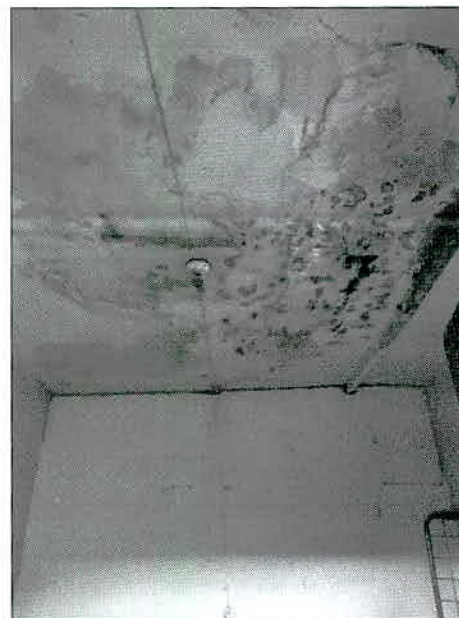
Foto 4. Humedad severa en cielo raso.
