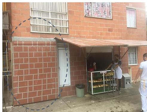
**Foto No. 2** Sistema de guardado de la cubierta, la cual queda adosada en la pared.
