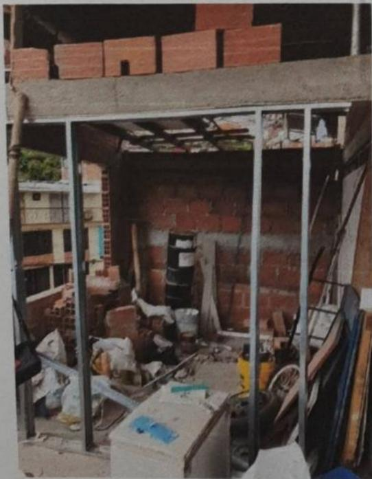
Foto No. 2 Detalle de las obras en el tercer piso, muros en ladrillo y en sistema drywall para adecuación de espacios.
