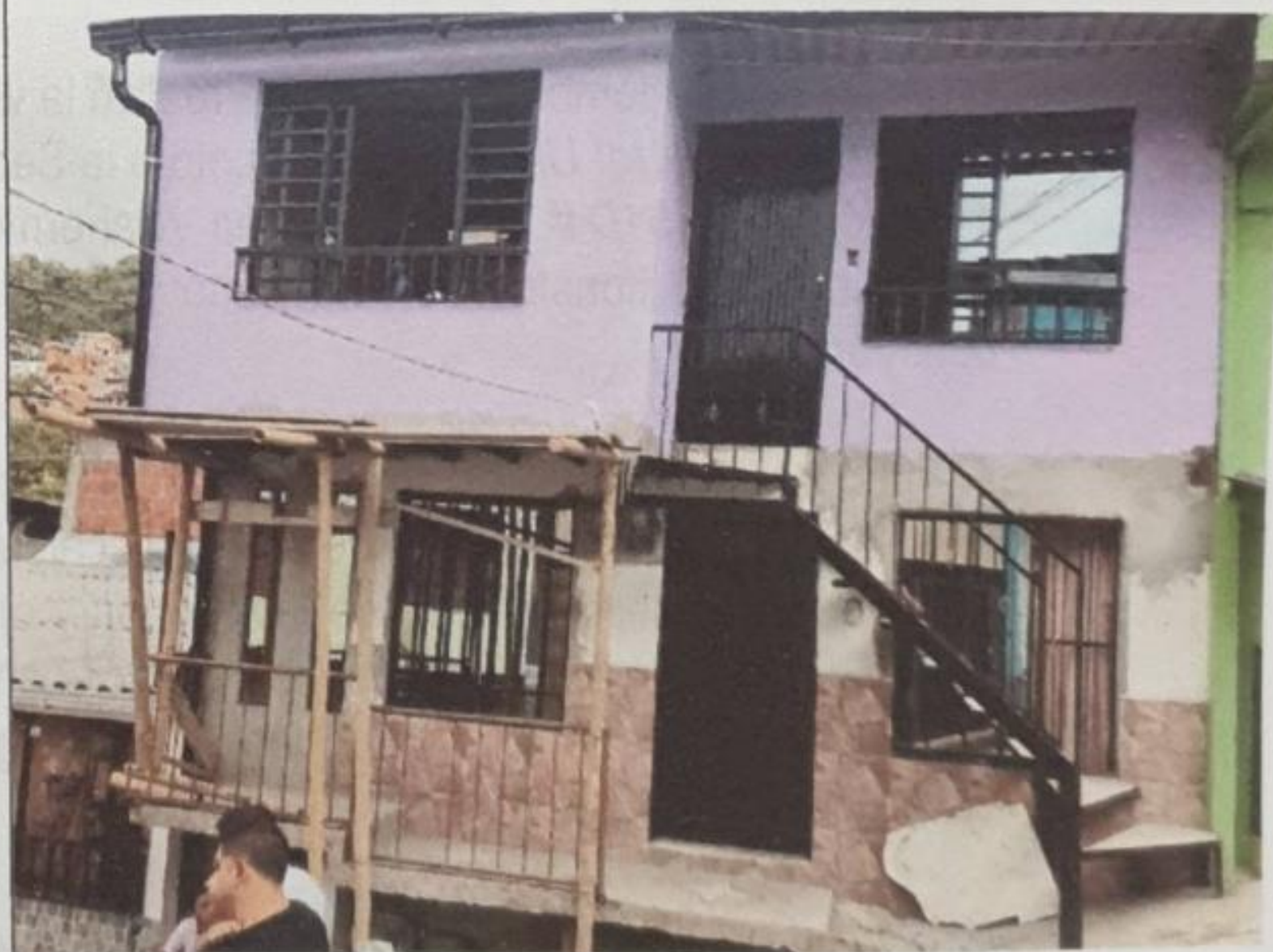
Foto No. 2 Se evidencia intervención de la fachada, escaleras metálicas en el andén de uso público y estructura en guadua y madera apoyada sobre el mismo andén de uso público.
