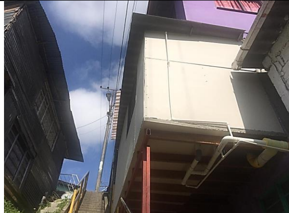
Foto No. 2 Se evidencia la culminación del cuarto de la vivienda
