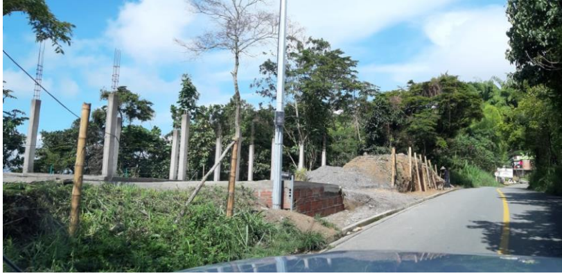
Imagen 2. Cimentación y estructura edificación al pie de la vía, aparentemente sin guardar los retiros.
