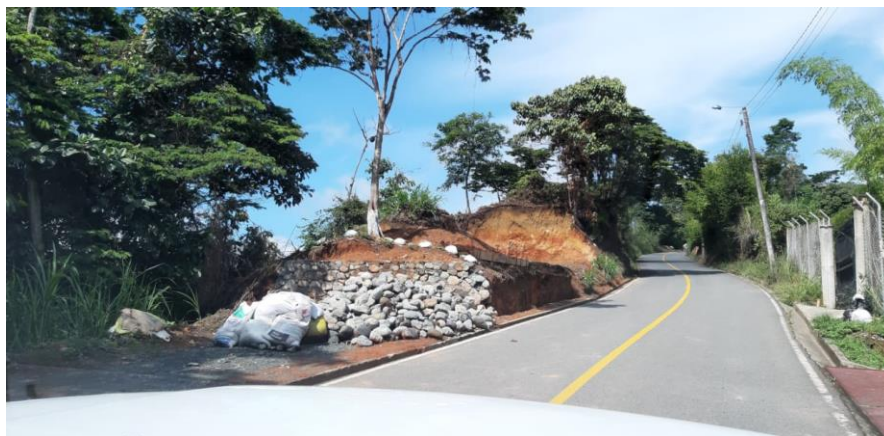
Imagen 1. Excavación y materiales de construcción al pie de la vía ingreso Vda San Peregrino
