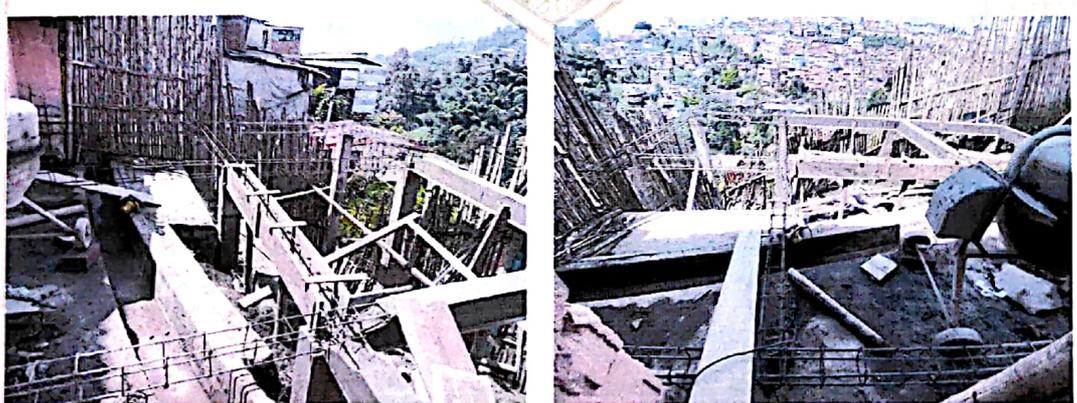
Foto No 2 y 3. Se observa la ampliación en la parte posterior de la vivienda, las columnas y vigas en concreto reforzado y el acero de refuerzo ya amarrado para las vigas aéreas.
