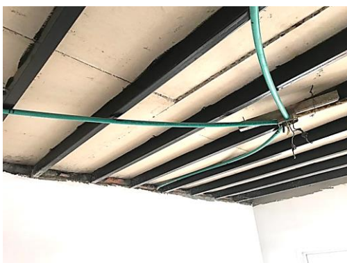
Foto No 3. Detalle de las viguetas metálicas y superboard para la losa de entrepiso del tercer piso.
