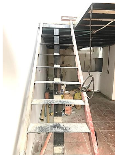
Foto No 4. Detalle de las escalas para acceder al tercer piso y la losa de entrepiso del tercer piso.
