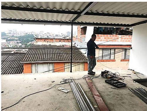
Foto No 5. Detalle de la terraza del tercer piso, se observa la cubierta.
