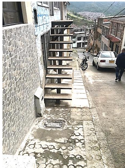
Foto No. 2. Detalle de la escala metálica invadiendo el andén considerado espacio público.
