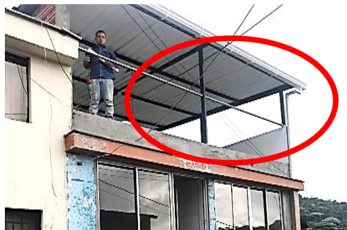
Foto No 6. Detalle de los muros del tercer piso, que dan registro a los vecinos. Personal trabajando en elementos de seguridad.
