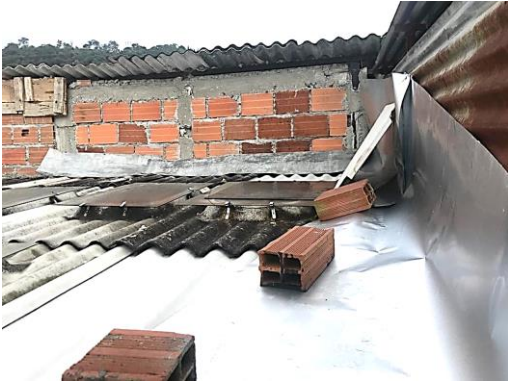
Foto No. 3 Flanche que se solicita sea retirado.
