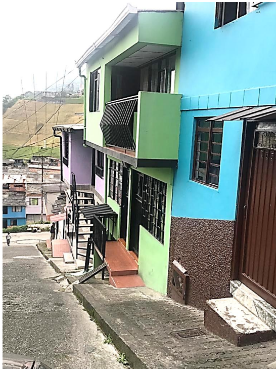
Foto No. 1 Fachada de las vivienda Calle 51D # 10-33.
