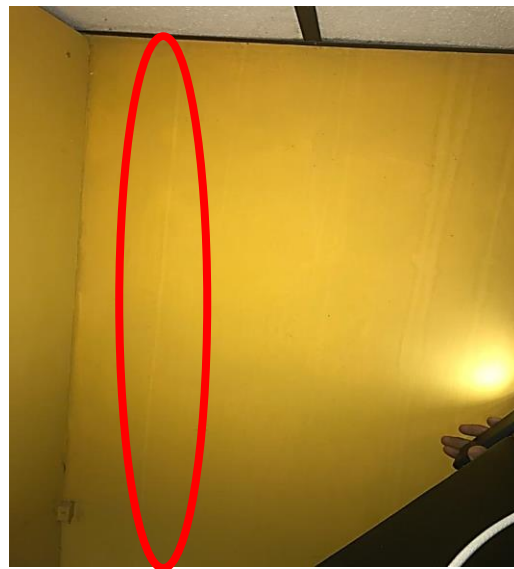
Foto No 2. Pared colindante con las fisuras
