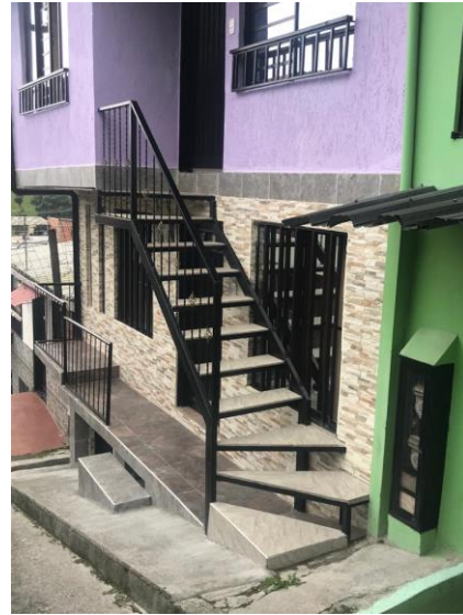
Foto No 2. Escalas de acceso al segundo piso, plancha de acceso al primer piso, invadiendo el andén peatonal, considerado espacio público.
