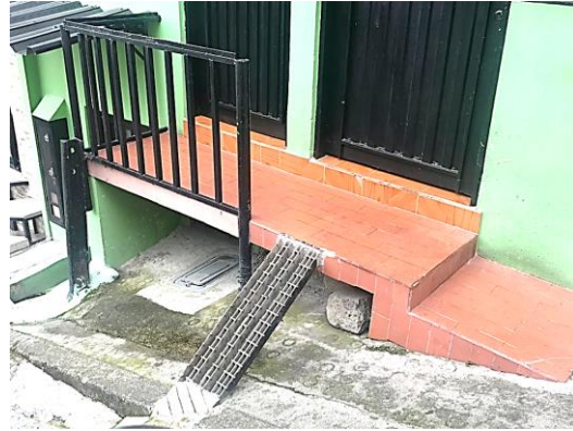
Foto No. 4 losa de acceso piso, plataforma para acceso de moto, invadiendo el andén peatonal, considerado espacio público.
