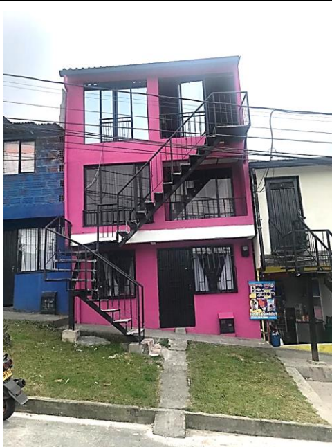
Foto No. 1 Fachada principal de la vivienda.
