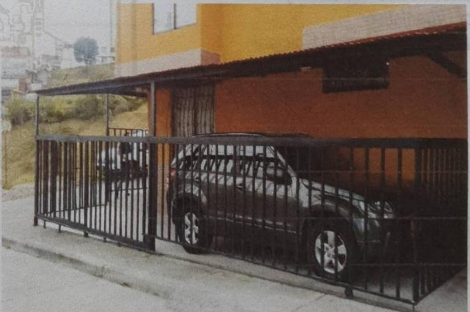
Foto No. 2 Detalle del cerramiento metálico cubierto, utilizado como parqueadero y el endurecimiento del piso.
