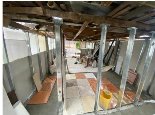
**Foto No. 3.** Detalle de la adecuación de muros y pega de enchape.
