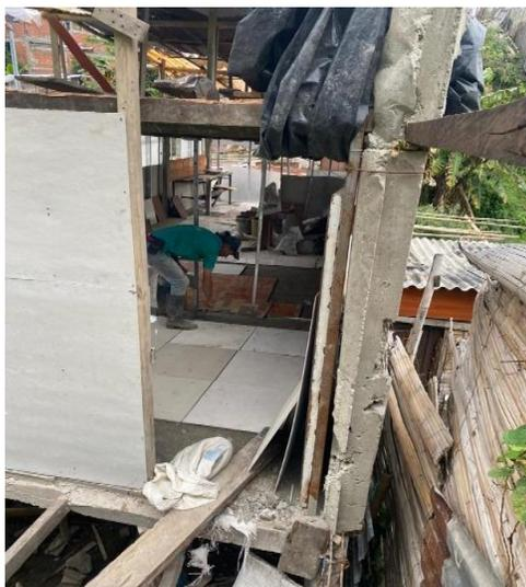
**Foto No. 4.** Detalle de la adecuación de muros y pega de enchape, y además personal laborando en la obra.
