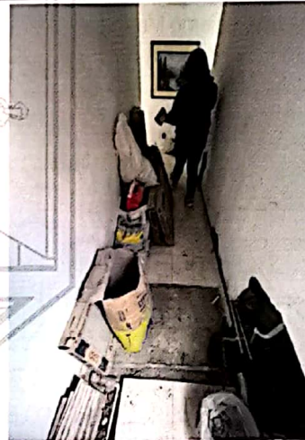
Fotografía No 6. Material de construcción al interior de la vivienda.
