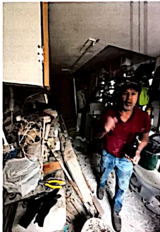
Fotografía No 5. Material de construcción al interior de la vivienda.
