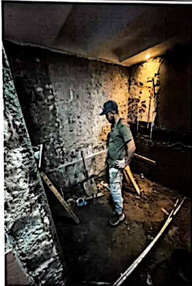
Fotografía No 3. Sustitución de pisos, empañetado de muros.
