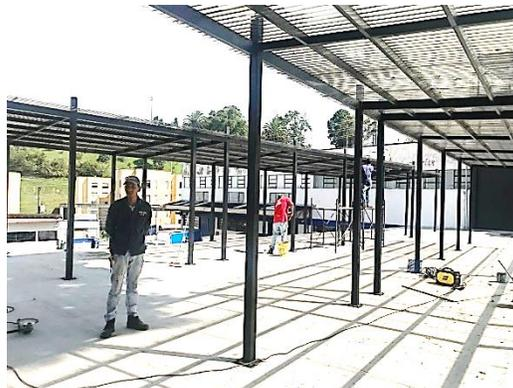
Foto No. 1 y 2 Construcción de estructura metálica, piso en superboard y teja traslúcida.
