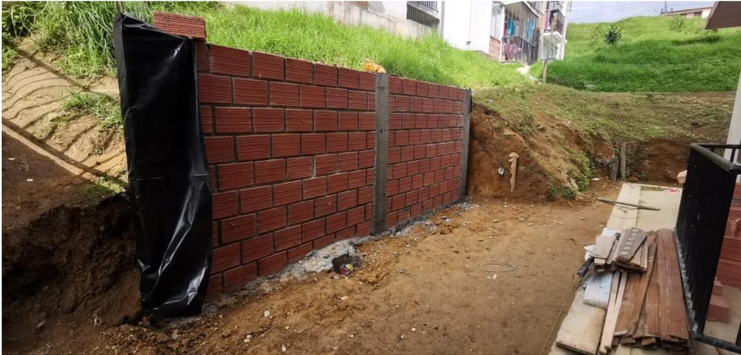
Foto No. 1 Detalles de construcción de muro en ladrillo farol y columnas en concreto reforzado.
