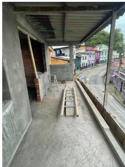
**Foto No 6.** Cubierta en teja de fibrocemento apoyada sobre perfilería metálica.
