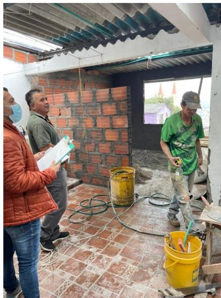
**Foto No 2.** Muros interiores en mampostería, vigas y columnas en concreto del tercer piso, personal de obra sin los debidos elementos de protección personal.
