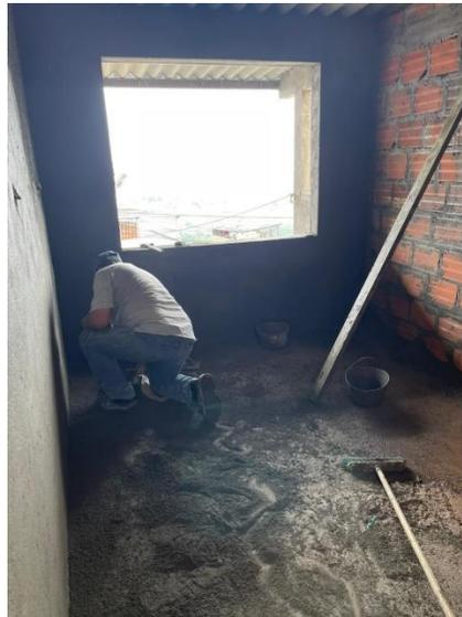
**Foto No 4.** Mortero de nivelación para una posterior instalación de enchape de piso.
