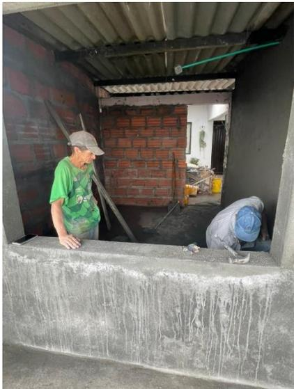
**Foto No 3.** Revoque de los muros y personal de obra sin los debidos elementos de protección personal.
