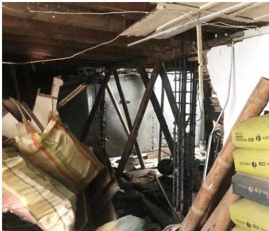
Fotografía No 3. Materiales al interior del predio y refuerzo para construcción de columnas.
