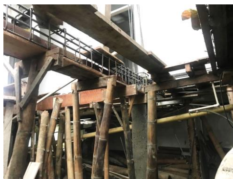
Fotografía No 6. Reforzamiento estructural de la vivienda.
