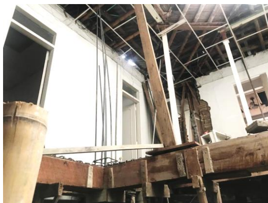
Fotografía No 5. Reforzamiento estructural de la vivienda.
