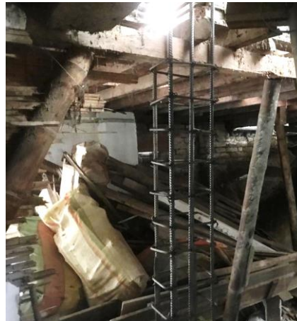
Fotografía No 4. Materiales al interior del predio y refuerzo para construcción de columnas.
