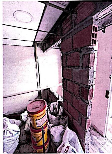
Foto No. 4. Trampa de acceso en mampostería con el fin de construir nuevo acceso a la vivienda en el tercer nivel.
