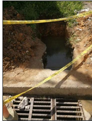
Se evidencia en el momento de la visita realizada, la presencia de empozamiento de las aguas en las excavaciones, no presentan olores ni color, indicando que no se tratan de aguas residuales.
