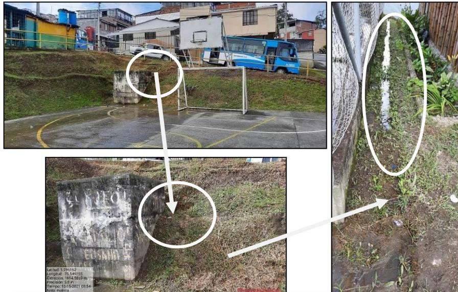
Fotografías Nos. 06, 07 y 08, se aprecia afloramiento de agua sobre uno de los taludes del polideportivo frente a esta vivienda, donde se ve el piso mojado y la salida de gran cantidad de agua, lo cual hace que mantenga inundada gran parte de la cancha, en el punto No. 03.
