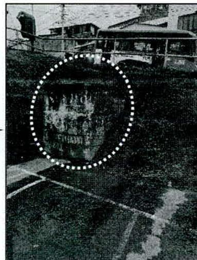
En el sitio mencionado (Cancha Microfutbol Terminal Busetas SOCOBUSES) ubicada en el sector, a un costado de la losa en concreto que conforma el escenario deportivo, se presenta filtración de agua a partir de la sección media del talud empradizado que se conformó para la cancha.
