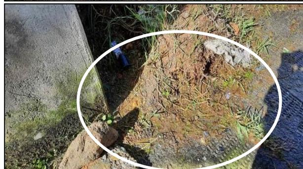
Fotografías Nos. 03, 04 y 05, se observa afloramiento de agua en el paramento de la vivienda de la solicitante de visita, se advierte salida de aguas y presencia de óxido de hierro, el cual hemos llamado como punto No. 02.
