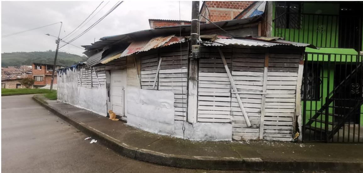
**Fotografía No 1.** Vivienda en materiales provisionales encontrada en el sitio de la visita. Se utiliza un poste eléctrico como parte estructural de la vivienda, además de ocuparse la totalidad del antejardín.
