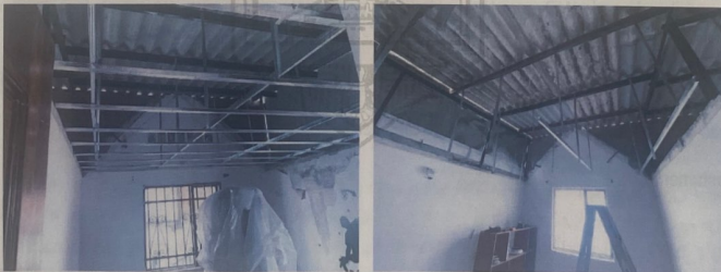
Foto No 1. Estructuración en omega y ángulos para la instalación del cielo raso
