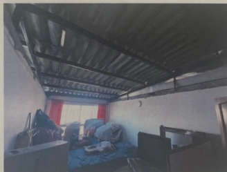
Foto No 3. Pintura de paredes interiores
