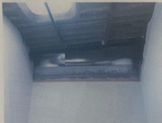
Foto No 2. Cambio de flanche lateral, para evitar filtraciones de agua.
