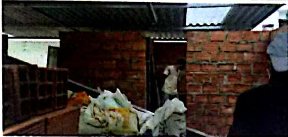
**Fotografía No 3.** Construcción de muros en ladrillo farol en la terraza de la vivienda.
