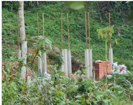
**Fotografía No 4.** Construcción de columnas en concreto, materiales de construcción sobre el predio.
