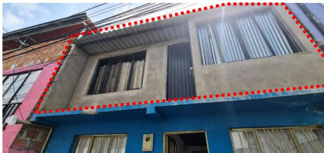
Segunda planta de ampliación de la vivienda, donde se evidenció la ausencia de pintura y acabados en la misma, también la ausencia de pasamanos o baranda de seguridad en el balcón y el proceso de revoque y acabado de la misma.
